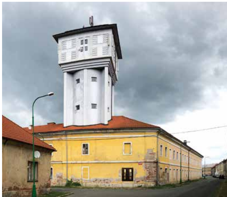
Obr. 1. Věžový vodojem v Jaroměři-Josefově byl vestavěn do starší existující zástavby (archiv projektu, 2018)
