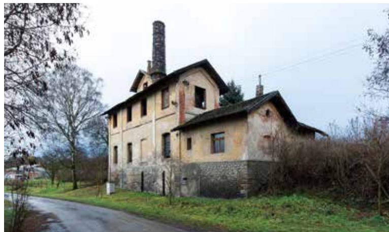
Obr. 4. Objekt drážního věžového vodojemu v Kolči nese celkem pět nádrží (archiv projektu, 2018)
