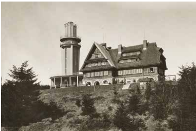
Obr. 6. Objekt rozhledny a věžového vodojemu na Suchém Vrchu vedle Kramářovy chaty (40. léta 20. století, archiv Radim Heinich)
