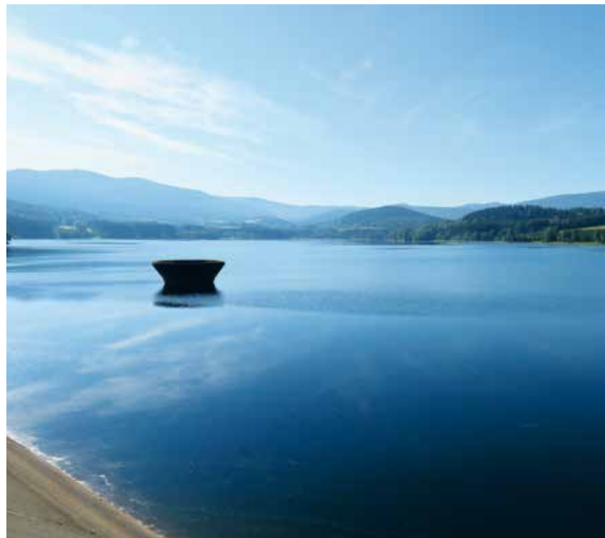
Obr. 2. Pilotní lokalita – VN Nýrsko, pohled jižně z tělesa hráze Fig. 2. Pilot site Nýrsko water reservoir, a view south of the dyke body
