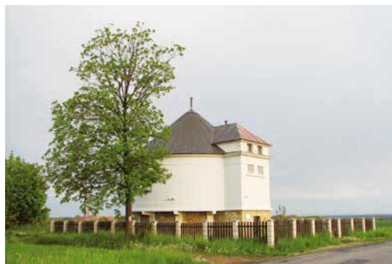
Obr. 1. Věžový vodojem Nebužely (archiv projektu, 2007) – takto konstruované vodojemy bývají někdy mylně označovány za „nadzemní“; podobný objekt bychom našli např. v obci Ločenice-Nesměň
