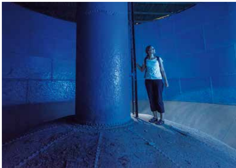
Obr. 6. Průzkum ocelové nádrže věžového vodojemu v Praze-Michli (okres Hlavní město Praha, archiv projektu, 2018)
