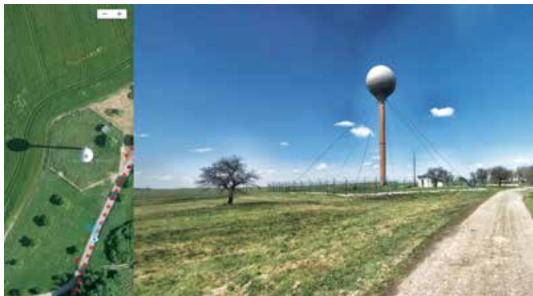
Obr. 5. Při identifikaci věžových vodojemů typu „hydroglobus“ na leteckých mapách usnadňuje práci typický šestiboký půdorys daný rozložením kotvících lan; lze např. využít pro odlišení od vzhledově podobného věžového vodojemu typu „aknaglobus“, který není lany ukotven (mapy.cz, 2017)
