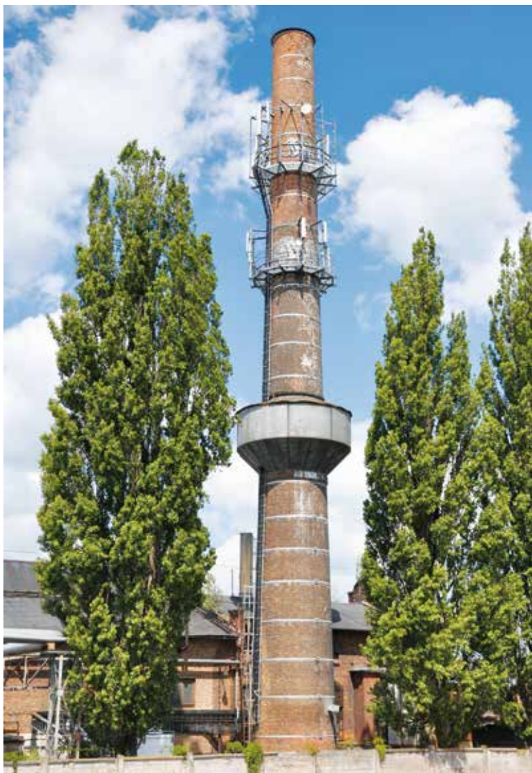
Obr. 4. Ocelový komínový vodojem bývalé válcovny trub v Ostravě-Svinově (okres Ostrava-město, archiv projektu, 2015)
