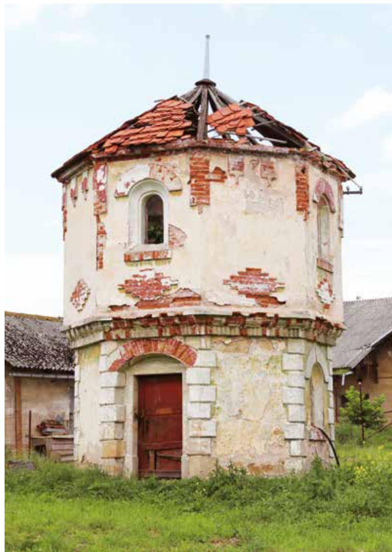
Obr. 2. Věžový objekt čerpací stanice v Hoříněvesi nesloužil k nesení nádrže (Jiří Polák, 2016) Fig. 2. The tower object of the pumping station in Hoříněves did not serve to sustain of the reservoir (Jiří Polák, 2016)
