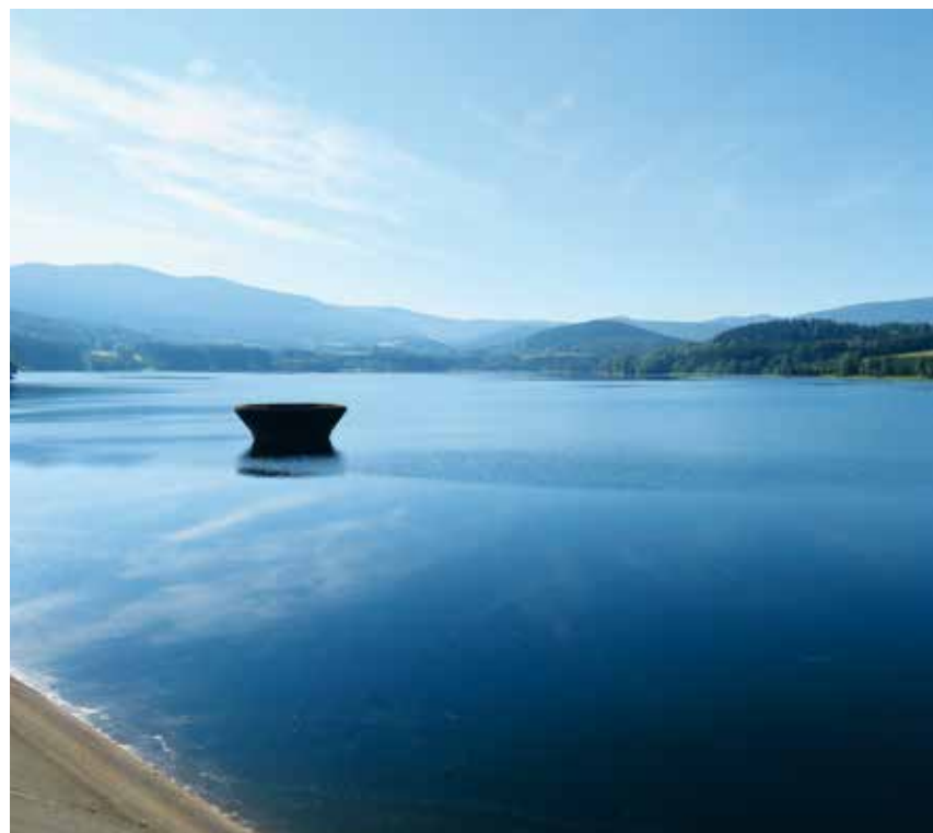
Obr. 2. Pilotní lokalita – VN Nýrsko, pohled jižně z tělesa hráze Fig. 2. Pilot site Nýrsko water reservoir, a view south of the dyke body
