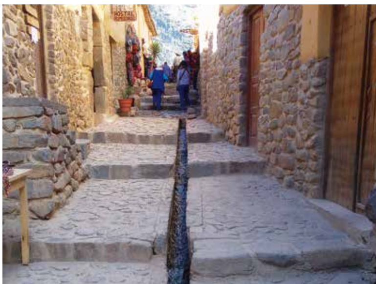
Ollantaytambo – rozvod vody městem
