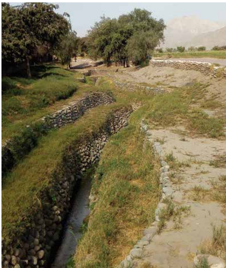
Cantaloc – vyústění kanálu z akvaduktu
