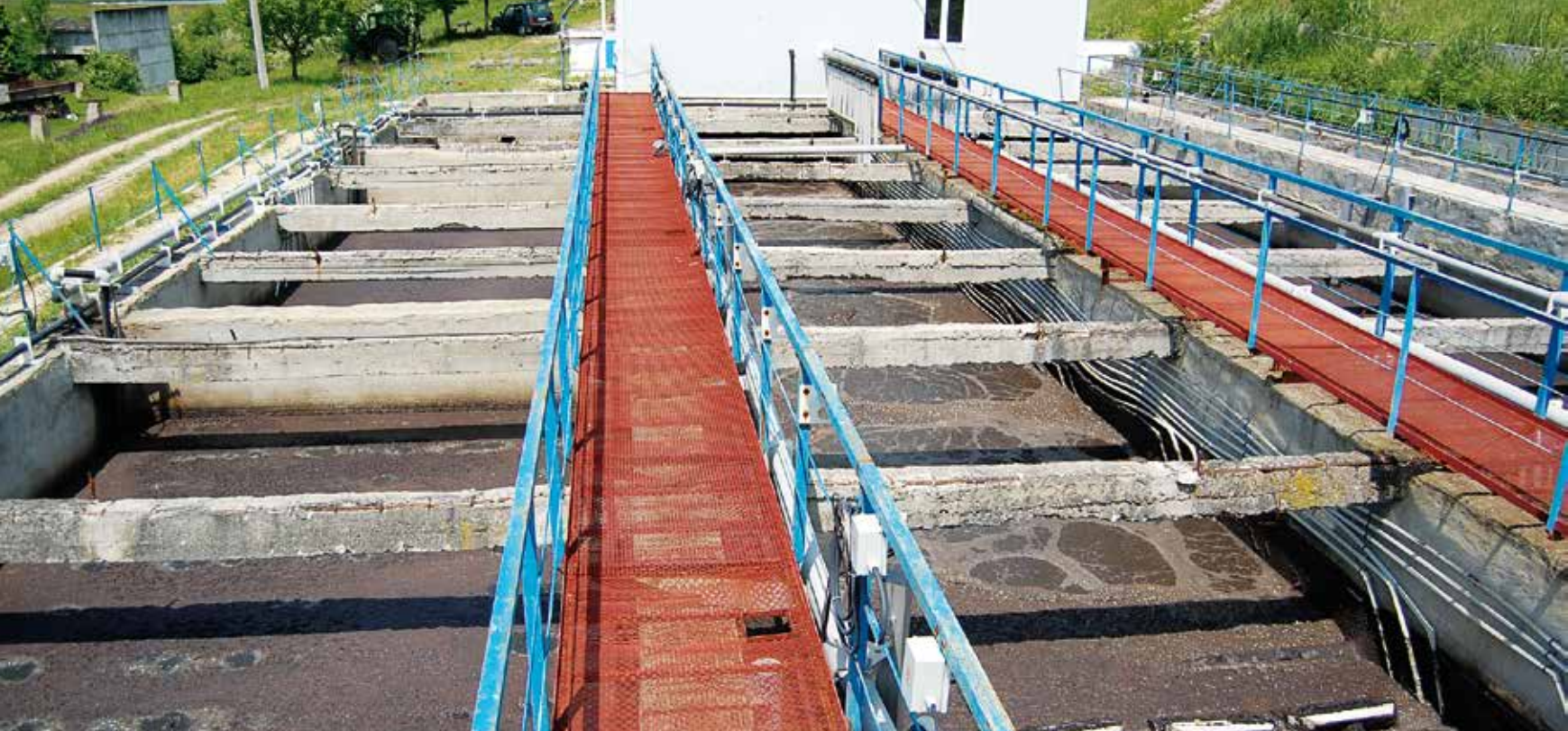
V Nisporeni byla stará čistírna přestavěna s českou podporou na technologii SBR
