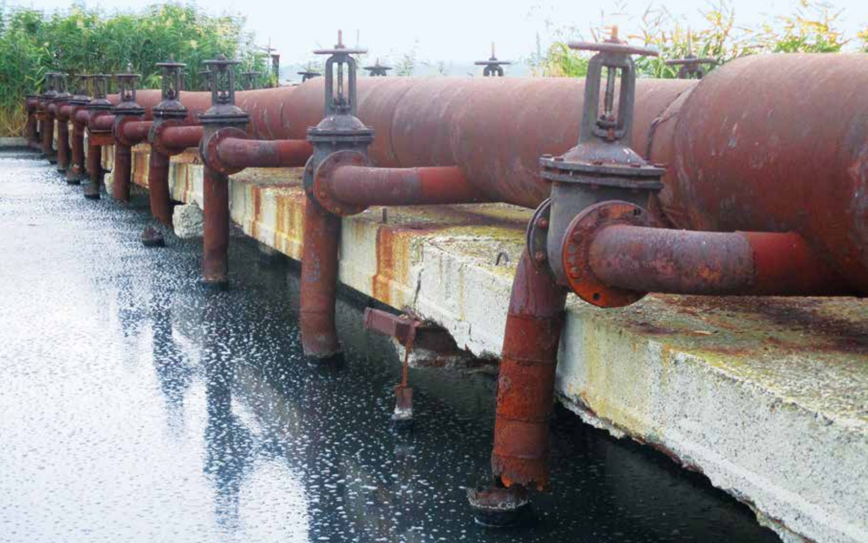
V Comratu je aktivace zcela odstavena a aerační systém nelze provozovat bez zásadní rekonstrukce
