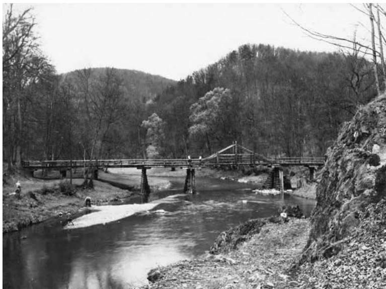
Obr. 11. Most přes řeku Svatku v horní části dnešní zátopy – nad Roklí Fig. 11. The bridge over the Svatka River – the upper part of a flooded area
