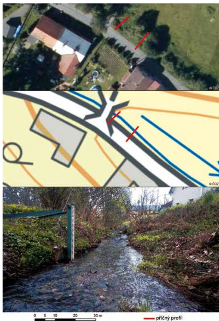
Obr. 1. Ukázka měřeného příčného profilu na úseku Husího potoka ve Vlkovicích u Fulneku
