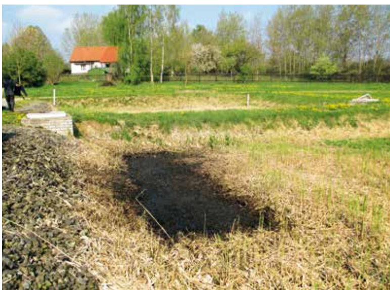
Obr. 2. Pohled na přítokovou zónu pravého kořenového pole očištěnou od stařiny a usazeného kalu
