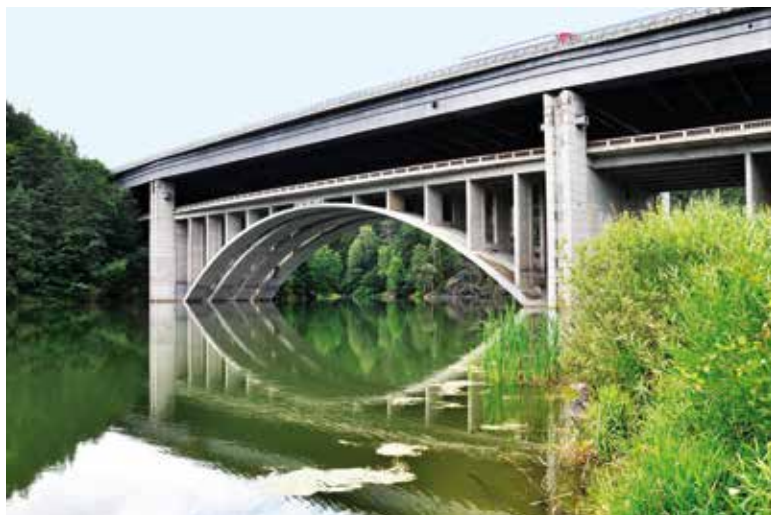
Obr. 1. Silniční most dálnice D1 překračující vodárenskou nádrž Švihov u obce Píšť (2016) Fig. 1. Road bridge of D1 highway crossing a water supply reservoir Švihov near the vil- lage Píšť (2016)
