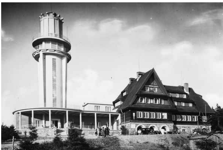
Obr. 1. Rozhledna s vodojemem na Suchém vrchu v roce 1933 (archiv Radim Heinrich) Fig. 1. Lookout tower with a water reservoir on Suchý peak in 1933 (Radim Heinrich archive)
