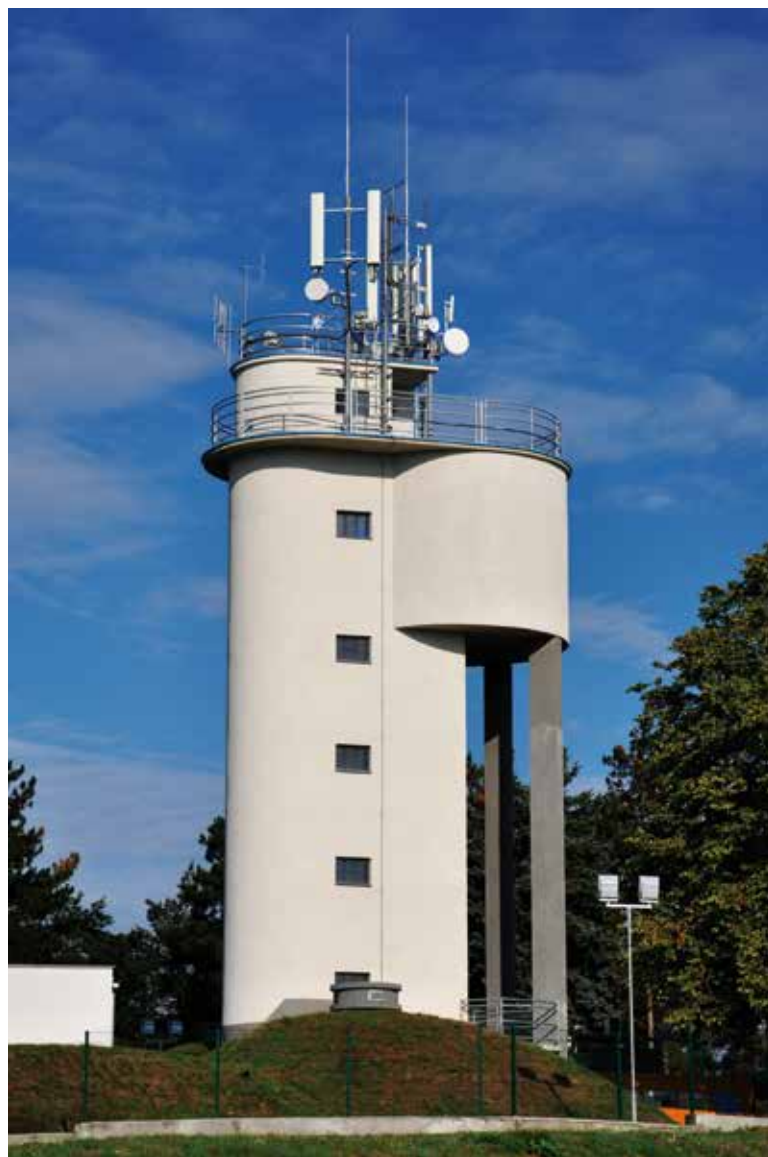
Obr. 4. Věžový vodojem v Třebíči (2015)
