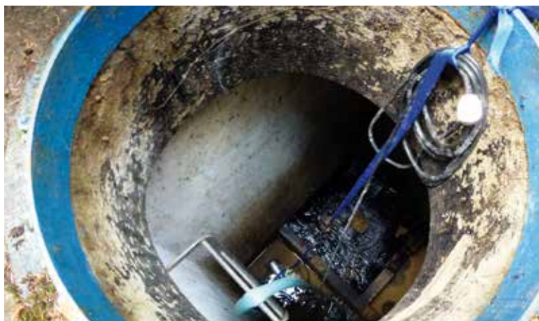
Velký Šenov – pohled do sběrné studny jímacího zájezu
