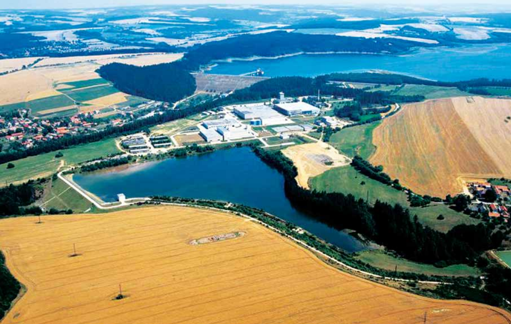
Obr. 1. Úpravna vody Želivka – celkový pohled (zdroj: Želivská provozní, a. s., 2015) Fig. 1. Drinking water treatment plant Želivka (source: Želivská provozní, a. s., 2015)
