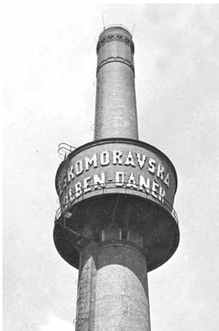
Obr. 2. Nejvyšší a nejmladší komín v areálu ČKD ve třicátých letech 20. století – zbořená kulturní památka (SOA Praha ČKD) Fig. 2. The largest and youngest chimney in the area of CKD in the thirties of the 20th century – demolished listed building (SOA Praha CKD)
