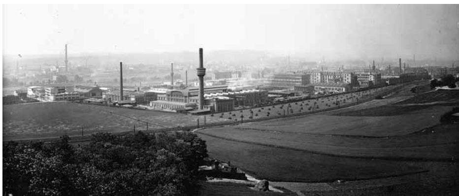
Obr. 1. Průmyslová oblast Vysočan se všemi šesti komíny s vodojemem ve třicátých letech 20. století (SOA Praha ČKD)
