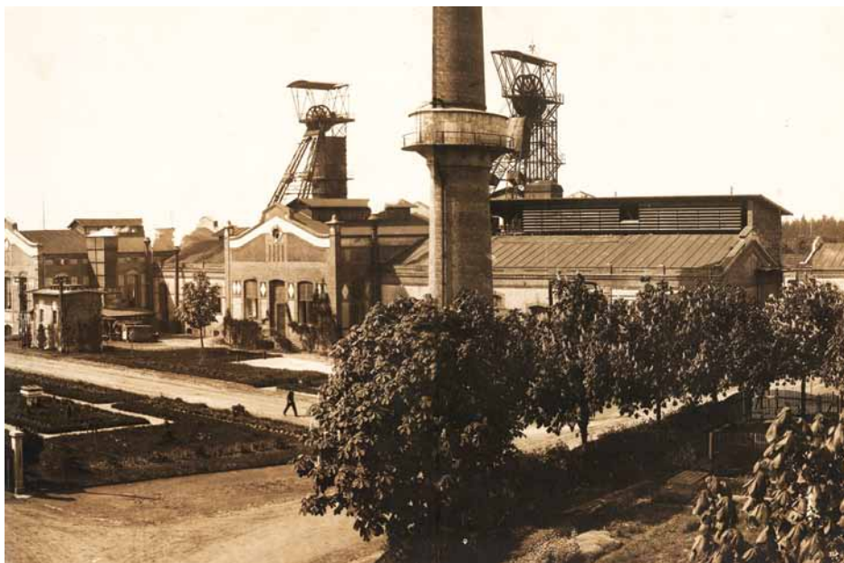
Obr. 8. Železobetonový komínový vodojem v areálu Dolu Ludvík v roce 1926 (Archiv OKD) Fig. 8. The reinforced concrete chimney reservoir in the Ludvík Mine area in 1926 (OKD Archive)
