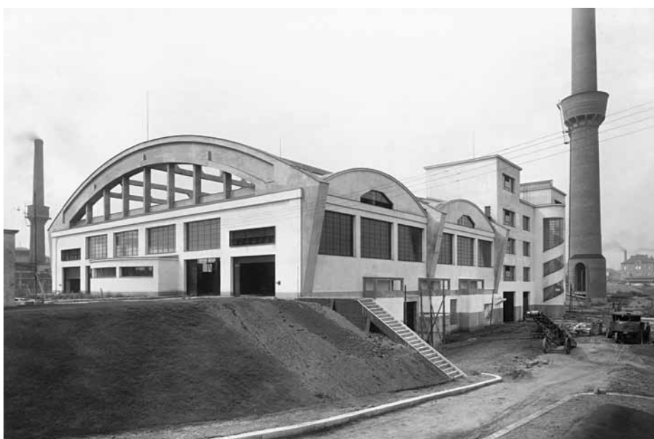
Obr. 4. Komín vysočanské spalovny (vpravo) a komín šroubárny (vlevo) na počátku třicátých let 20. století (SOA Praha Kapsa a Müller) Fig. 4. The chimney of Vysocany incinerator plants (right) and the chimney of a screw factory (left) in the early thirties of the 20th century (SOA Praha Kapsa a Müller)
