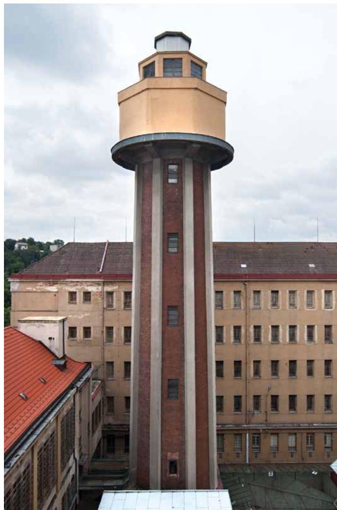
Obr. 5. Komín doplněný o železobetonový vodojem v areálu vazební věznice v Ruzyni (2014)
