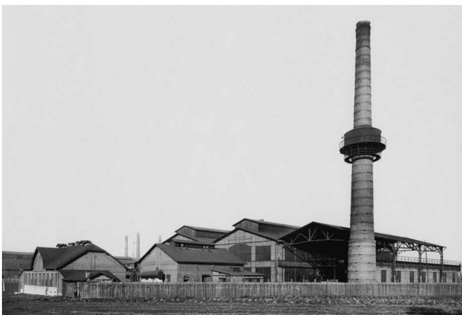
Obr. 7. Válcovna Fryštátských železáren a dominanta komína s vodojemem v roce 1924 (Archiv Vítkovice).
