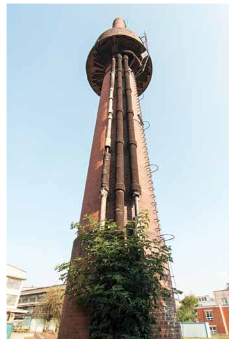
Obr. 3. Komín bývalého ústředního skladiště ve Vysočanech (2014) Fig. 3. The chimney of a former central storehouse in Vysocany (2014)
