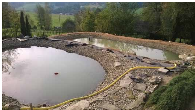
Obř. 5. Soustava dočišťovacích nádržích za domovní ČOV Fig. 5. The system of post-treatment stabilization ponds for domestic wastewater treatment plant
