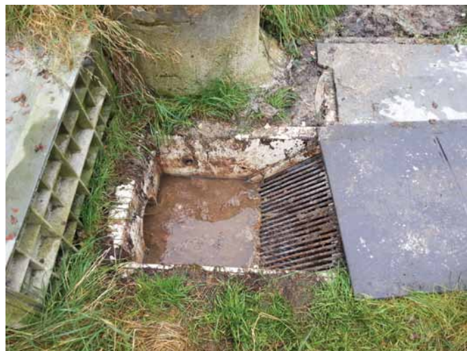
Obr. 2. Správná instalace česlí Fig. 2. Correct installation of screen bars
