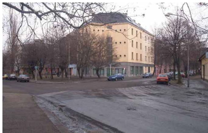
Budova pobočky VÚV v Ostravě
