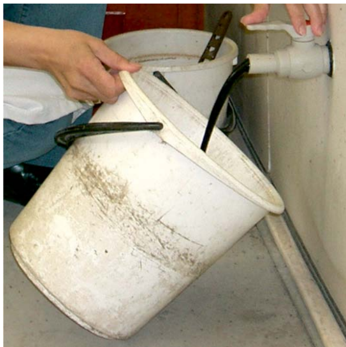
Obr. 4. Odtah přebytečného kalu z domovní ČOV Fig. 4. Desludging of a domestic WWTP
