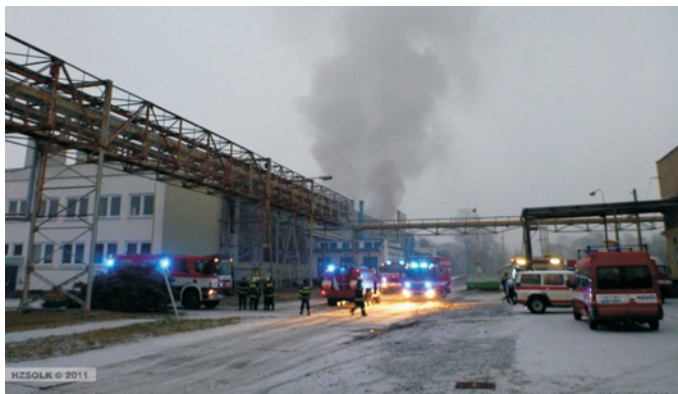
Obr. 3. Požár galvanovny v Postřelmově (foto HZS Olomouckého kraje) Fig. 3. Fire of galvanizing plant in Postřelmov (photo of Fire Brigade of the Olomouc Region)
