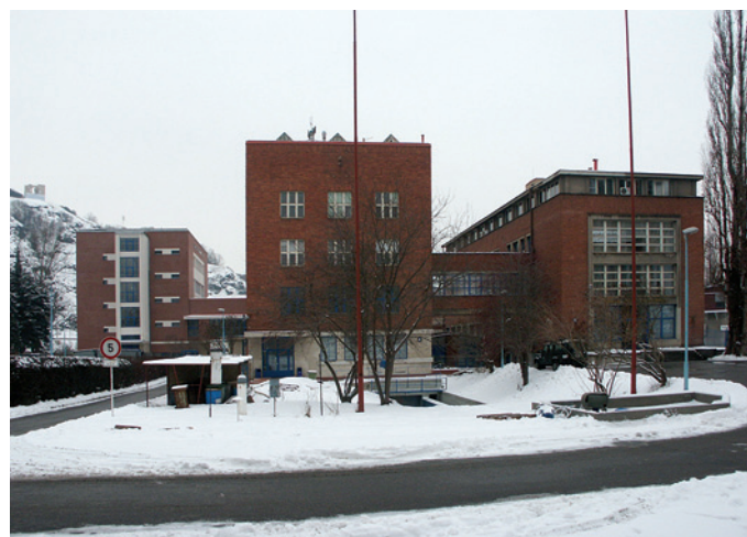
Pohled na budovy VÚV
