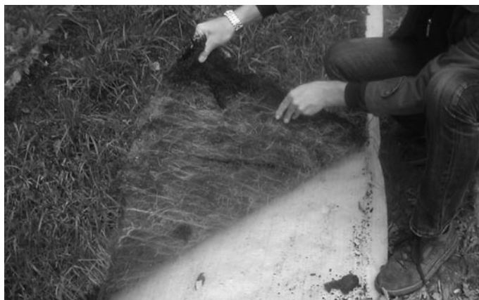
Obr. 4. Ukázka prokořenění „sendvičové“ konstrukce – říjen 2010
