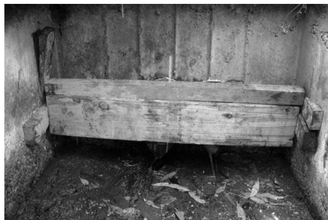
Obr. 2. Uzavření tělesa zemního filtru
