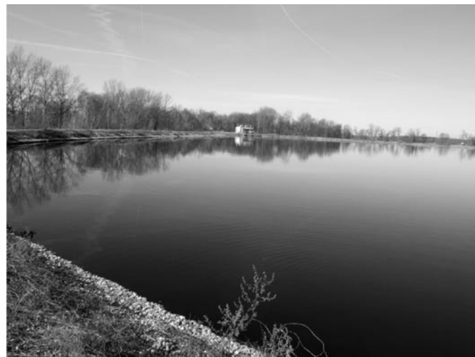
Obr. 1. Retenční nádrž Lhotka pro zadržení a homogenizaci průmyslových odpadních vod ze závodu Synthesia
