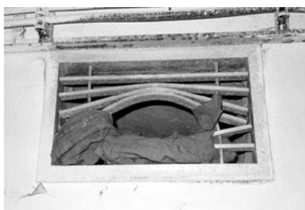
Obr. 5. Nevhodně zajištěné větrací otvory v prostoru manipulační komory s čerpací stanicí
