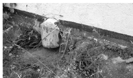
Obr. 5. Nevhodně zajištěné větrací otvory v prostoru manipulační komory s čerpací stanicí
