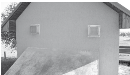
Obr. 7. Příklady vhodného zajištění větracích otvorů rámečky s filtrační textilíí
