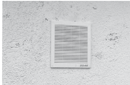
Obr. 8. Zajištění větracího otvoru krycí mřížkou s osazenou filtrační jednotkou a) vnitřní strana vstupního prostoru do akumulační komory, b) vnější strana vstupního prostoru do akumulační nádrže
