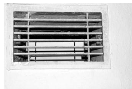
Obr. 5. Nevhodně zajištěné větrací otvory v prostoru manipulační komory s čerpací stanicí
