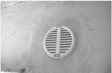
Obr. 8. Zajištění větracího otvoru krycí mřížkou s osazenou filtrační jednotkou a) vnitřní strana vstupního prostoru do akumulační komory, b) vnější strana vstupního prostoru do akumulační nádrže
