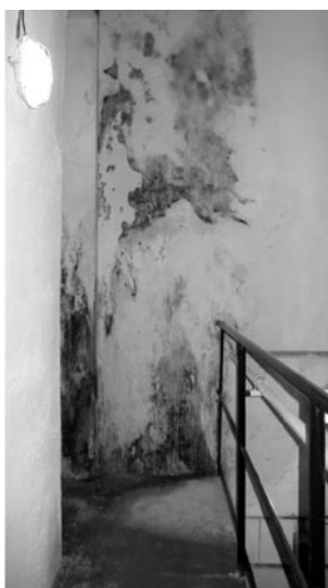
Obr. 4. Vlhké zdi akumulační nádrže porostlé řasami v prostoru manipulační komory s čerpací stanicí, v níž jsou velká okna
