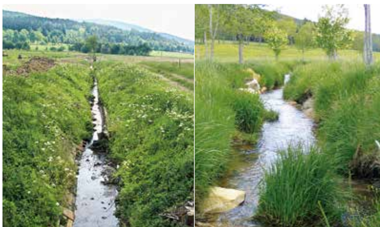
Obr. 4. Koryto potoka Borová před revitalizací (vlevo), revitalizované koryto v roce 2006 (vpravo)
