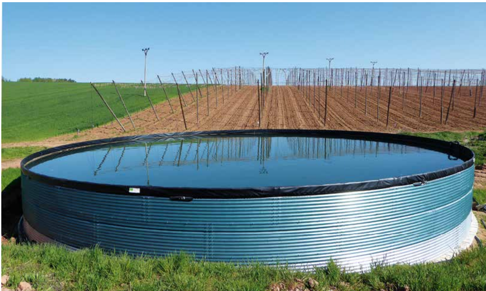
Obr. 3. Malá montovaná závlahová nádrž realizovaná přímo v místě odběru vody pro závlahu (fotografie: Josef Ježek, Chmelařský institut, s. r. o.)
