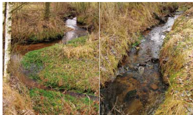
Obr. 5. Revitalizované koryto potoka Borová v roce 2016
