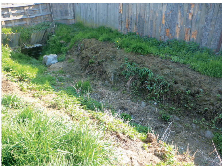
Obr. 4. Ochranný příkop nad obcí Chlístovice Fig. 4. Ditch for protection of Chlístovice
