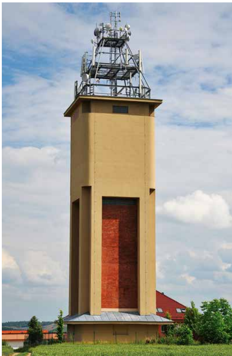
Obr. 9. Konstrukce s telekomunikační technikou na střeše vodojemu v Benátkách nad Jizerou (2015)
