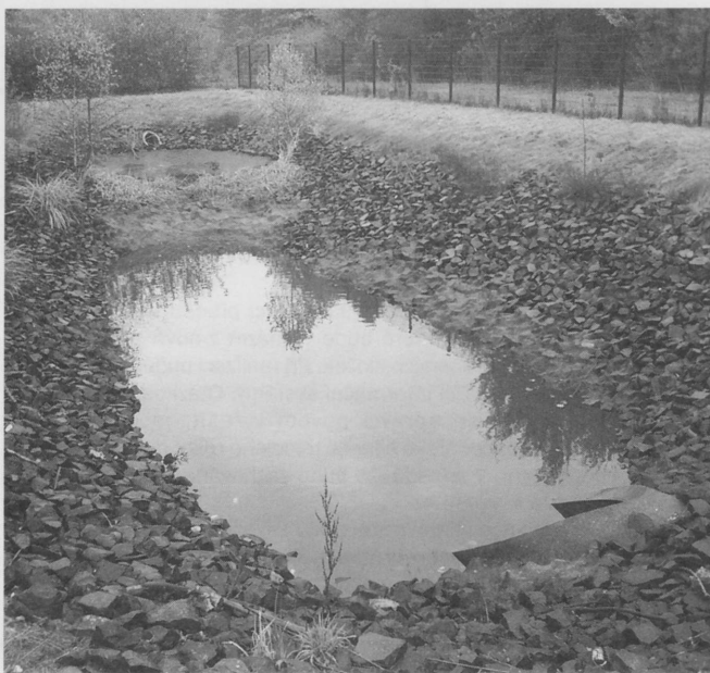
Obr. 1. Starší typ dešťové usazovací nádrže z 80. let (1982, Německo)
