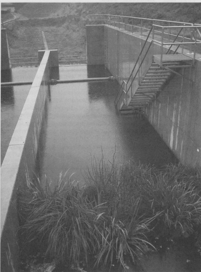
Obr. 2. Nový třístupňový typ zařízení se zemním filtrem (2002, Německo)
