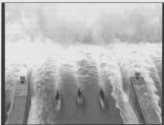
Obř. 1. Vodní dílo Slapy dne 14. 8. 2002, 16:05 – odtok přes bezpečnostní přeliv (pohled z hráze)
