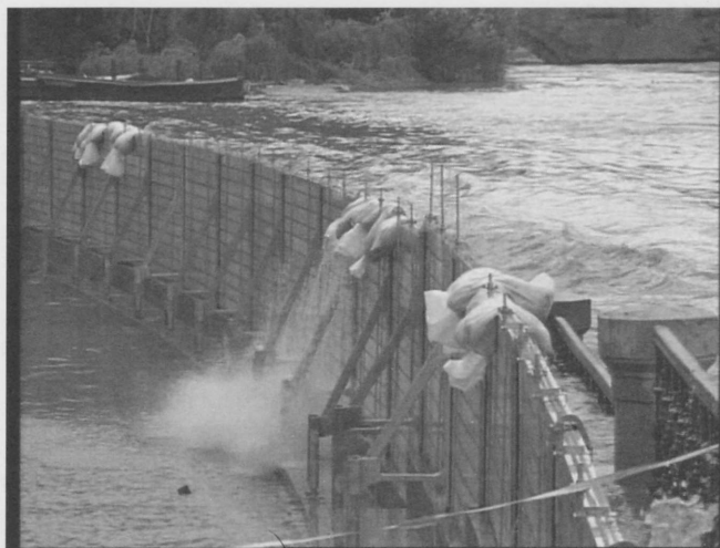
Obř. 2. Praha, Alšovo nábřeží dne 14. 8. 2002, 12:30 – mobilní hrazení; povodňový průtok Vltavy kulminuje
