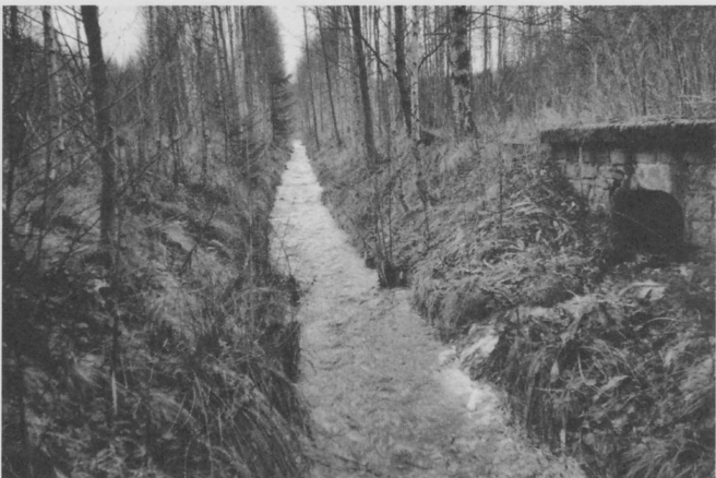
Obr. 3. Mnoho úseků toků, v nichž se perlorodka říční dosud vyskytuje, bylo v minulosti zcela nevhodně upraveno; kromě snížení samočistící schopnosti toku takto zanikl i pro perlorodku nezbytný přírodní charakter dna (foto O. Simon)
