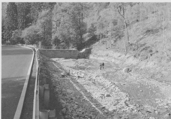
Obr. 6. Prostor přehrážky, který byl při povodni zaplněn
