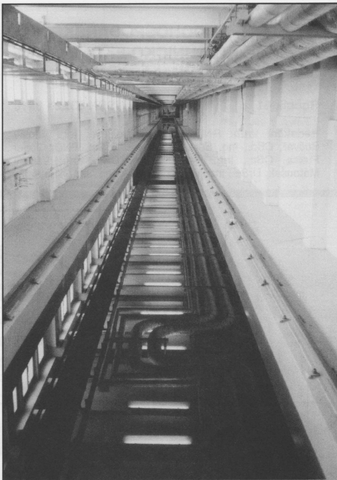
Obr. 2. Současný pohled do interiéru pokusného žlabu (foto L. Ramešová)
