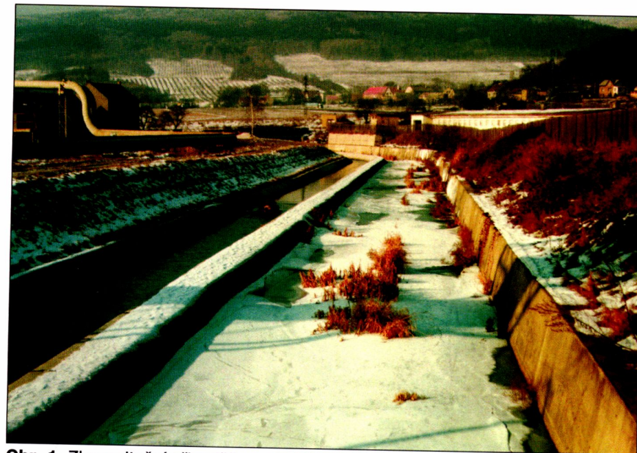
Obr. 1. Zkapacitnění přivaděče vody Ohře – Bílina – ochrana Dolu Nástup
