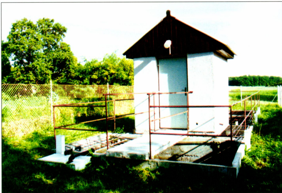
Čistírna odpadních vod s přerušovaným provozem v Radovesici u Kolína (návrhová kapacita 500 až 550 obyvatel, sestava dvou reaktorů – DIBLOK)
