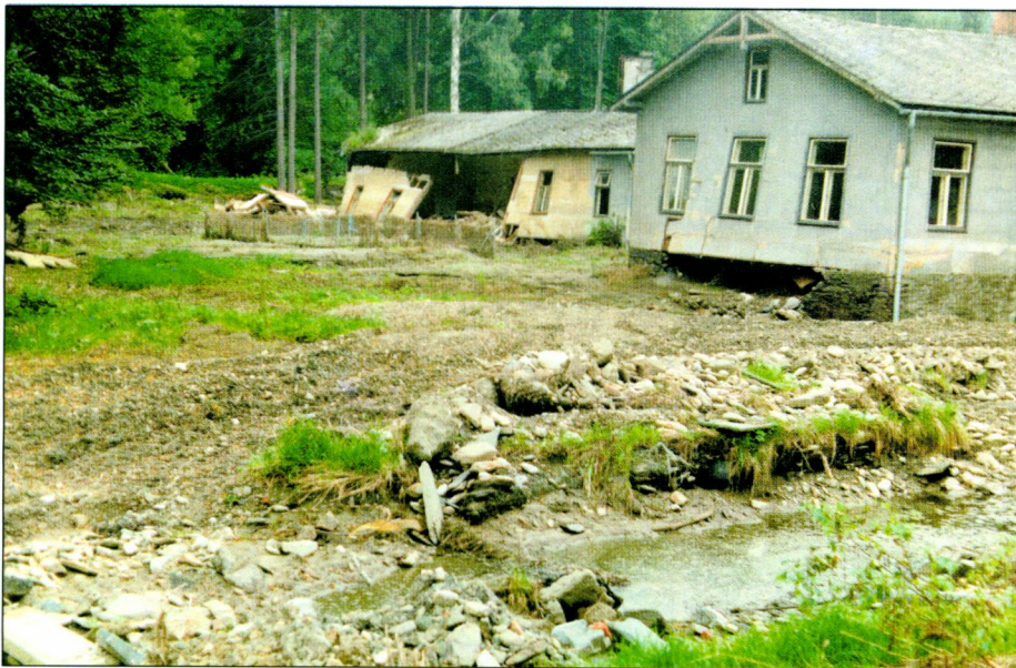
Poškozené domky v Nových Heřmínovech na Opavě (v místech uvažované nádrže) – stěny domů jsou vytlačeny prouděním vody
