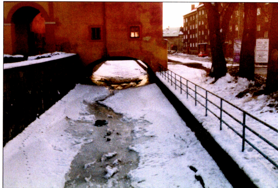
Kritický profil Chomutovky v km 31,705 u knihovny; ledová hmoty sahá 0,6 m pod korunu zdiva – po oteplení v poslední dekádě ledna došlo k prolomení a poklesu ledové pokrývky o 0,8 m (stav 29. 1. 1997)
