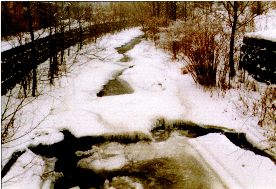
Ledový práh na Chomutovce v km 33,100 (stav 19. 1. 1997)
