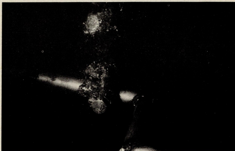
Obr. 2. Tryska rozmrazovacího zařízení VD Stanovice v činnosti
