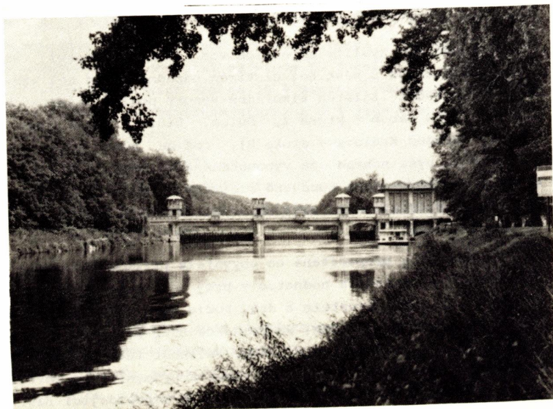
Jez a elektrárna v Poděbradech (foto M.Sedláček)
