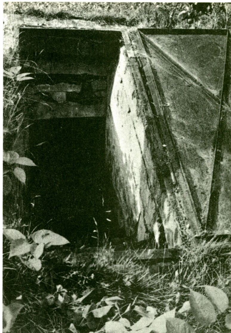
Obr. 8. Štola č. 1 "Královka": vstup do štoly na zahradě mateřské školy (foto autor)
