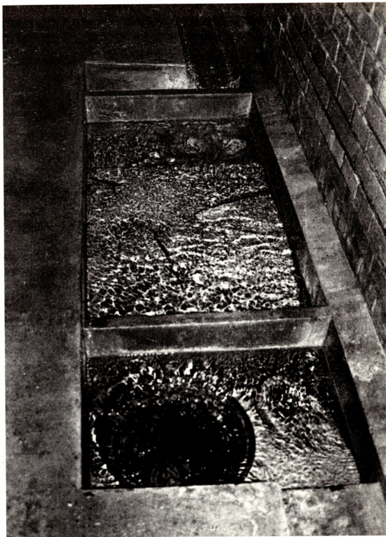
Obr. 13. Štola č. 3: trojitá jímka pro záchyt připlaveného písku; přívod vody do jímky ze žlábků; trychtýř zaústěného jímacího potrubí v třetí části jímky (foto J. Štastná)
