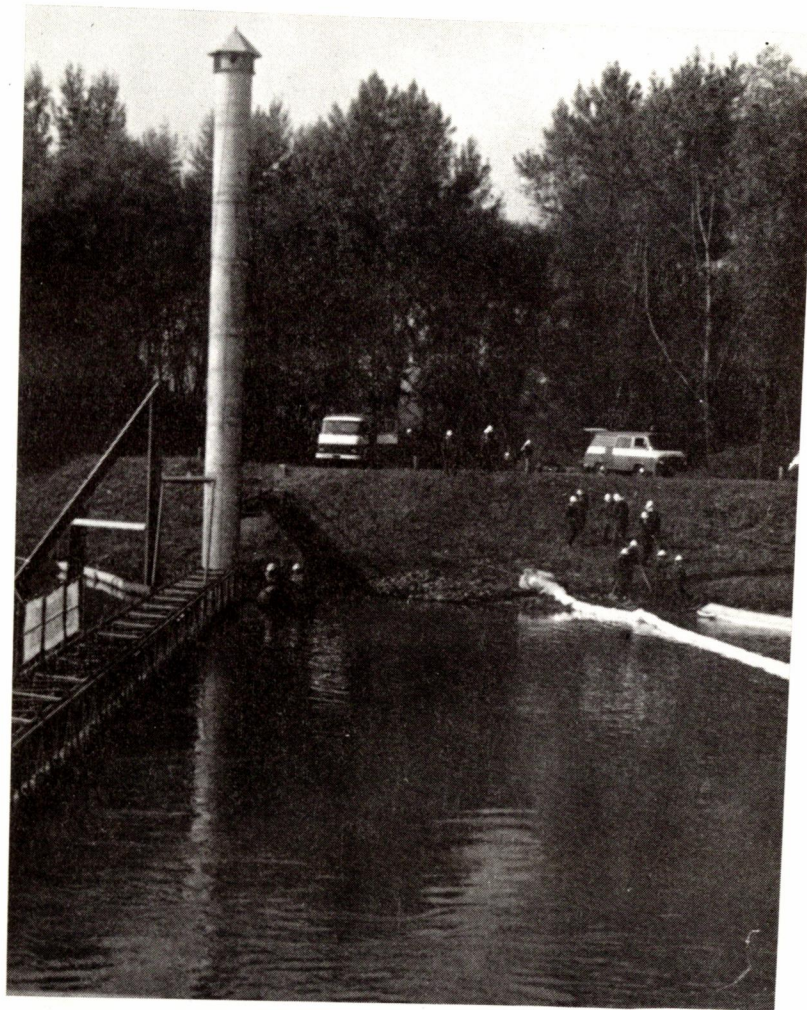
Obr. 3: V levé části spuštěná mostová norná stěna, vpravo textilní sorbční norná stěna se skupinou požárníků. Vše v profilu Hrušov. (Voda teče zleva doprava.)
