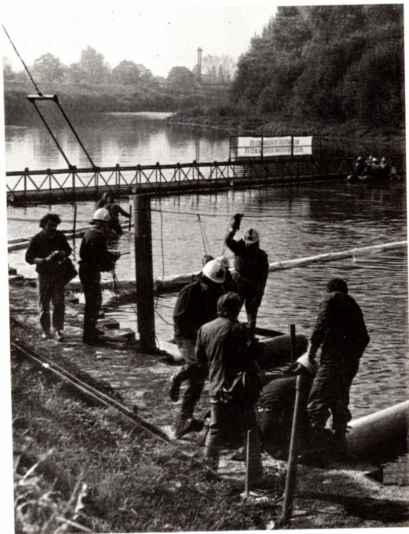
Obr. 4: Totéž z jiného pohledu. Navíc je vidět nosný sloupek s přípevněným lanem, na němž je navázána nafukovací norná stěna (část je vidět jako vodorovný válec v pravém spodním rohu).
