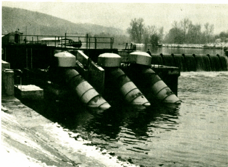
Obr. 1: Původní vorová propust u jezu na Vltavě v Klecanech
