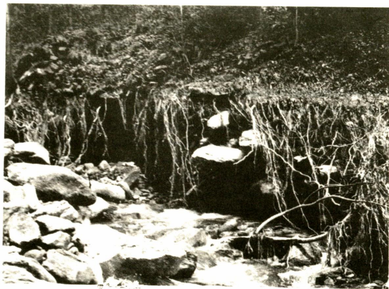
Obr. 2: Podemlévající břeh říčky Čisté v Černém dole
