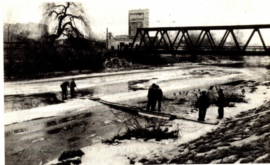
Obr. 3: Přípravy k odstřelu zácpy na Moravě u železničního mostu v Olomouci.
