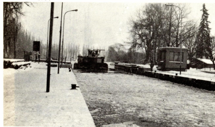
Obr. 8: Proplavování ledové tříště z HPK v Brandýse n. L. plavební komorou při pomoci tlačného remorkéru s hráběmi
