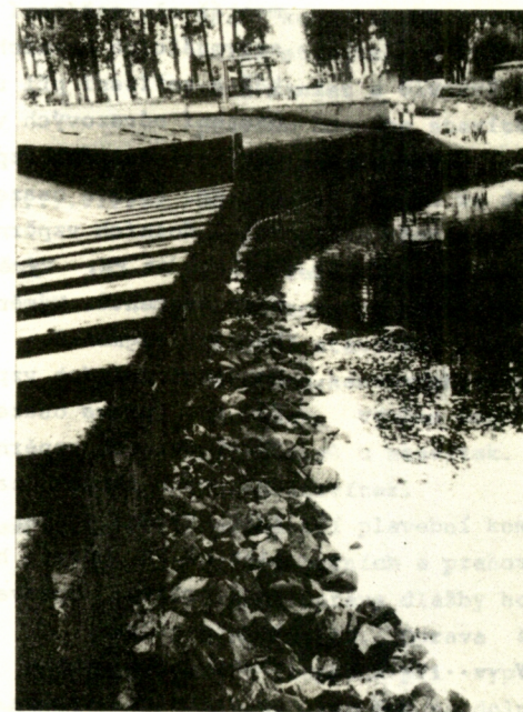
Foto 1: Technickobezpečnostní prohlídka jezu Veletov při vypuštěné kolínské zdrži
