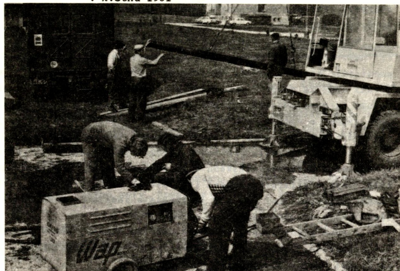
Obr.2: Demontáž prstence servoválce horních sklopných vrat na plavební komoře Veletov v květnu 1981 / obě foto autor /
