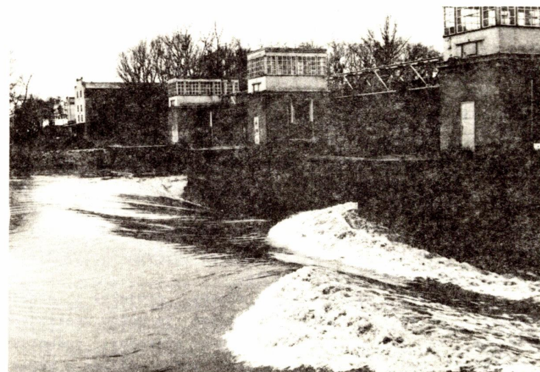
Obr. 4: Klavary 12.3. - průtok převáděn 2 poli (1 zahrazeno provozním hrazením po havárii v červenci 1980)
