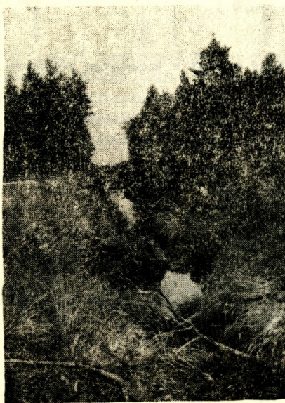
Úprava vodního režimu rašelinných ložisek. V pozadí odvodňovací příkop, vyhloubený bahenním rypadlem Poclair.
