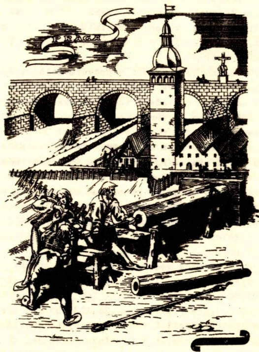
Staroměstská vodárna - ročníci při vrtání dřevěného potrubí / foto z muzea Pražských vodáren /
