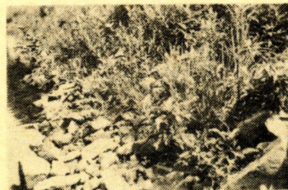
Obr.1 a 2. Lužnice ( Frahelž - Klec ). Pohled na úsek s kamenným pohožem zarostlým plevelem a vodním rostlinstvem.
