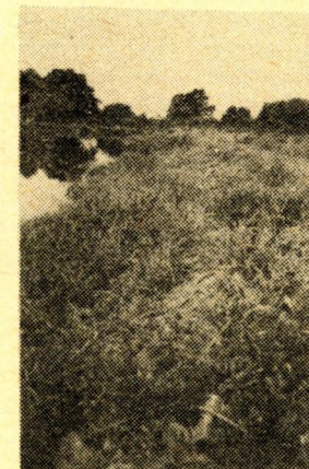
Obr.1 a 2. Lužnice ( Frahelž - Klec ). Pohled na úsek s kamenným pohožem zarostlým plevelem a vodním rostlinstvem.
