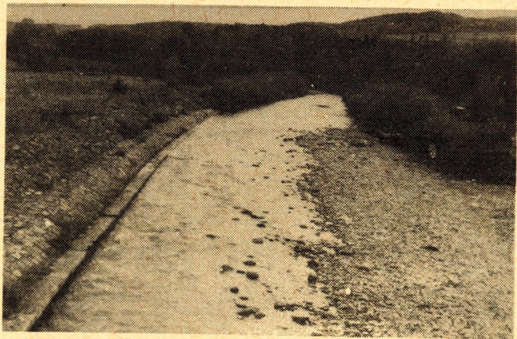
Obr. 5. Veselá - trať nad mostem 1968. Prohlubování dna. V pozadí trať zpevněna vegetačním opevněním.
