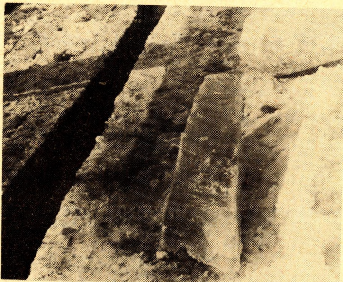
Obr.2. Řezání ledu u jezového zařízení.
