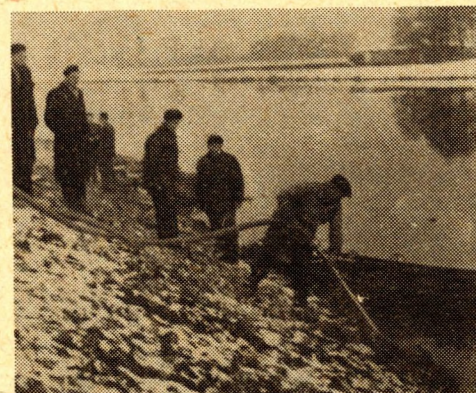
Obr. 3. Odstraňování nánosů tlakovou vodou. Způsob OVSH Kroměříž.
